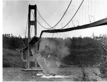
**Figure 11.4.:** Effondrement du pont de Tacoma suite à sa résonance induite par le vent.
