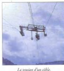
La tension d'un câble.
