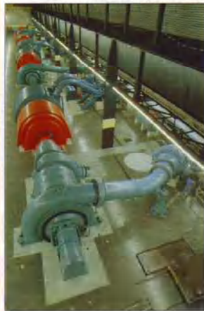
Salle des machines de la centrale de Veytaux. Au premier plan: la pompe, puis le moteur-alternateur, et enfin la turbine de l'un des quatre groupes.
