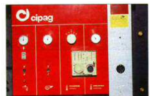
Une chaudière moderne: la pompe et le vase d'expansion sont intégrés.
