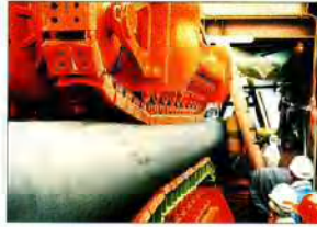
Pose d'un gazoduc dans le Léman (en face de Clarens). Le gaz naturel provient d'Italie.
