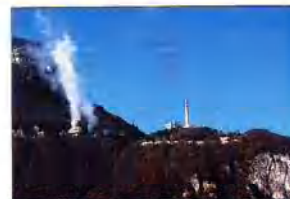
L'ancienne centrale thermique de Chavillon.
