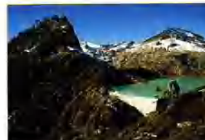
Barrage d'une centrale à accumulation (Emosson).
