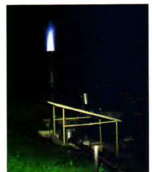
Brûleur à gaz
