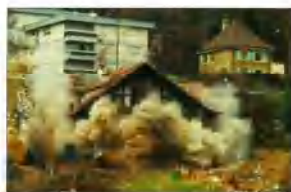
Implosion d'un bâtiment. (Photo mise à disposition par l'Office fédéral des troupes P.A.)
