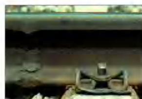
Soudure de rail de chemin de fer par aluminothermie.
