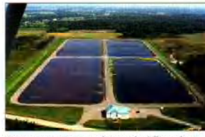
Sur cette vue aérienne, on distingue les différents bassins permettant l'épuration des eaux usées.
