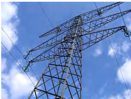
FIG. G.1 – Ligne de haute tension Pylône et isolateurs d'une ligne de 400 kV 28
