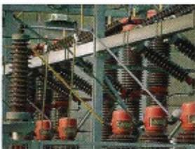
de tension et d'intensité d'un courant alternatif. Des sites produisant l'électricité aux consommateurs, en passant par les différents réseaux de transport, les valeurs de tensions exploitées ne sont pas les mêmes et demandent donc des ajustements. C'est là qu'interviennent les transformateurs. Par exemple, ils haussent la tension à la
