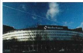
La Maison de la radio , à Paris, est chauffée selon ce principe.
