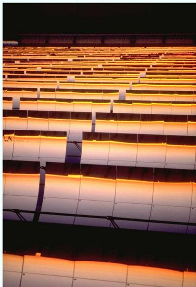
De l'eau dans des tubes au foyer de fours solaires paraboliques.
