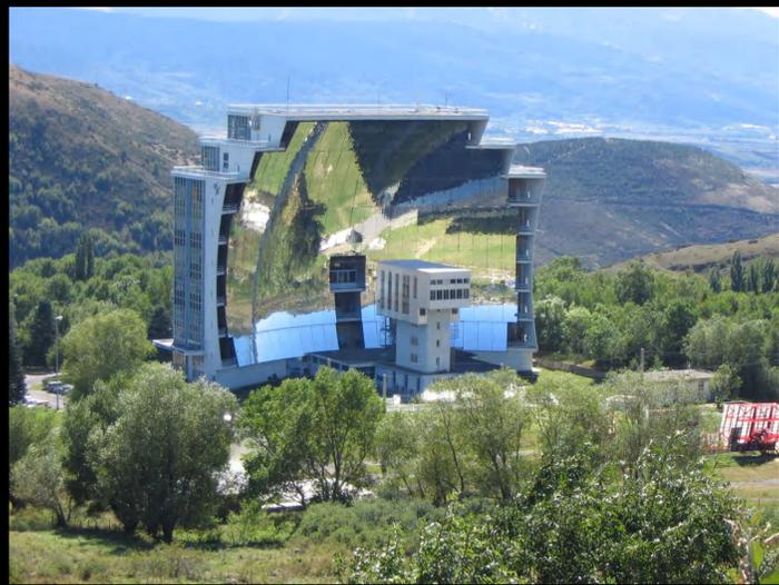
Depuis bien longtemps d'importantes recherches sur les énergies renouvelables sont réalisées. Ici, le four solaire d'Odeillo qui fut mis en service en 1970 et a une puissance thermique de 1 MW. Il permet par exemple l'étude des chocs thermiques et on y atteint des températures supérieures à 3000 degrés.
