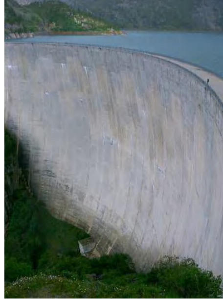
FIG. 4.3 – Barrage d'Emosson D'une hauteur de 180 m et largeur de 560 m 38
