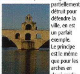
partiellement détruit pour défendre la ville, en est un parfait exemple. Le principe est le même que pour les arches en demi-cercle. La clé de voûte permet à l'arche de se maintenir et le poids du pont est supporté par les arches seules. Mais étant donné que les arches rejoignent le pilier obliquement, la force transmise par l'arche vers le sol n'est pas verticale. Ceci ne pose pas de problème au niveau des piliers puisque les forces des 2 arches s'opposent. En revanche, le
